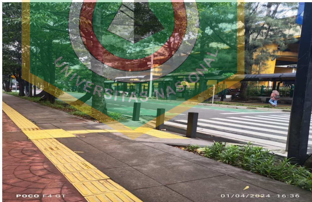
Gambar 1. Guiding Block, Ramp dan Passing Place pada Trotoar Ramah Disabilitas kawasan Kemang, Jakarta Selatan.
