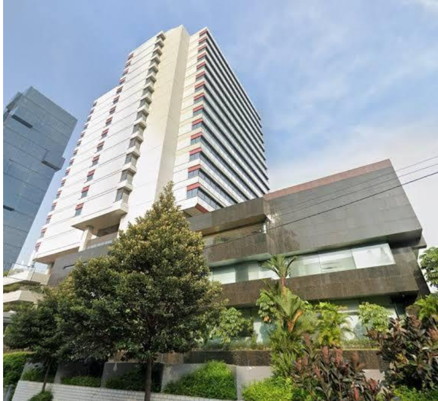
Gambar 4.1.1 Gedung Wisma Antara Sumber : Google
