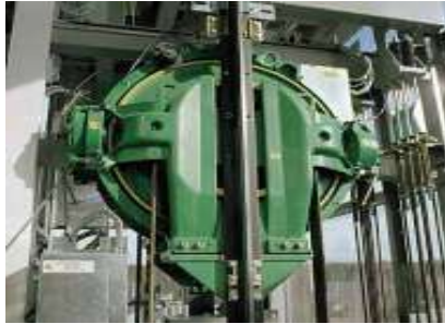
Gambar 12. Motor Penggerak
