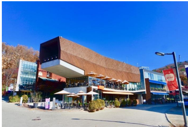
Gambar 2.27 : Bangunan yang unik dan terkenal di Heyri Art Village
