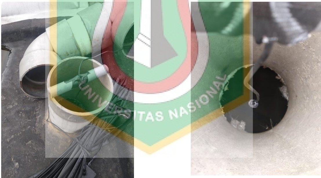
Gambar. Pemasangan Sensor Volume Biogas
