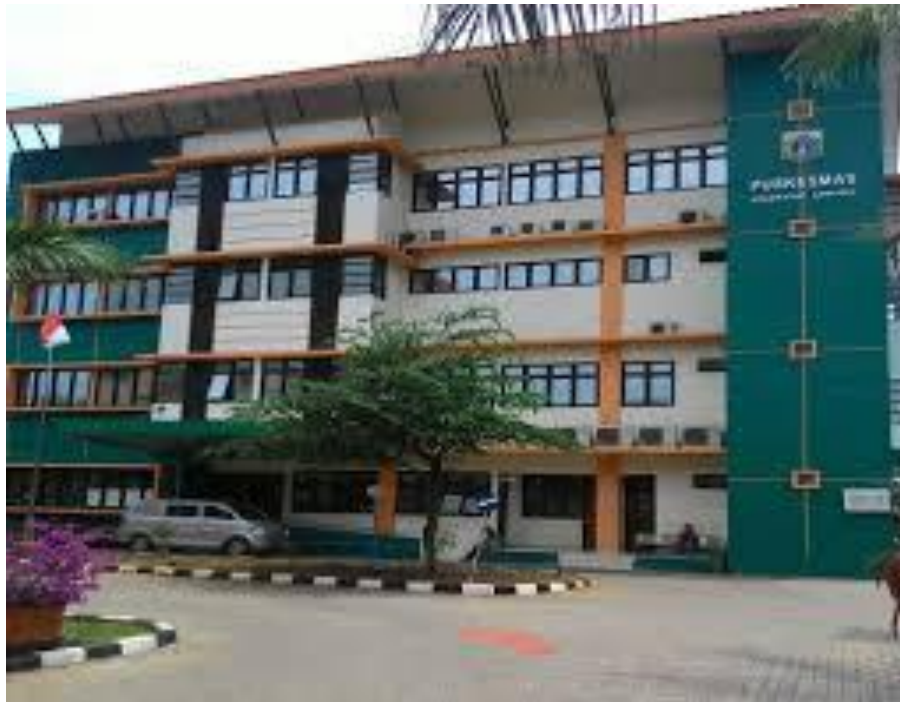
Gambar 4.1 Gedung Puskesmas Cipayung Jakarta Timur
