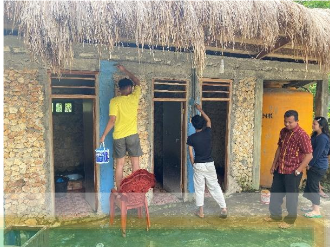
Gambar 5. 15 Proses Pemugaran Toilet di Kampung Adat Prai Ijing Sumber: Penulis
